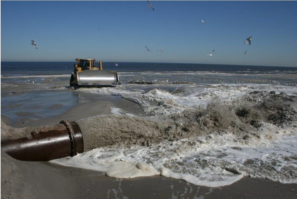
Figuur 7 Foto van een strandsuppletie bij Hoek van Holland, waarbij het zandwatermengsel met grote kracht op het strand wordt gespoten, waarna het water afstroomt naar de zee. De bulldozer leidt de stroming in goede banen en verdicht het zand (opname 2007, bron: https://beeldbank.rws.nl , Rijkswaterstaat / Harry van Reeken)
